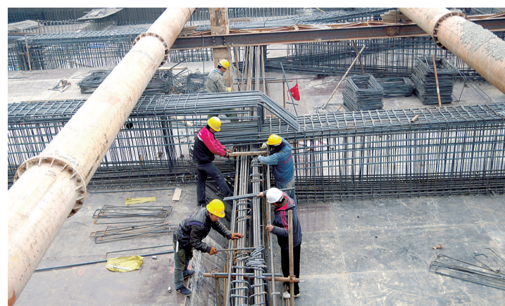
新龙路站内结构主体施工已完成。
