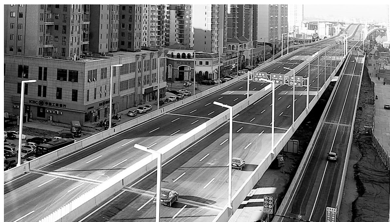
已经完工通车的大学路以西段的陇海路高架二层。
