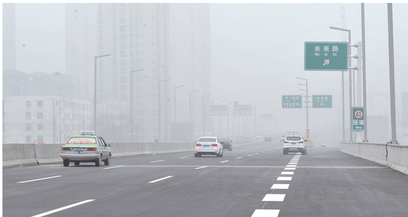
昨日上午,陇海路高架未来路段全部贯通。
