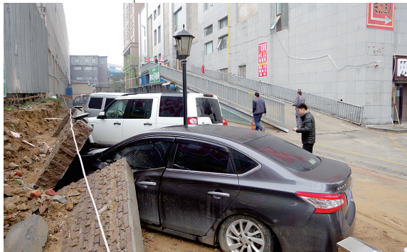
倒塌的围墙砸中6辆汽车
