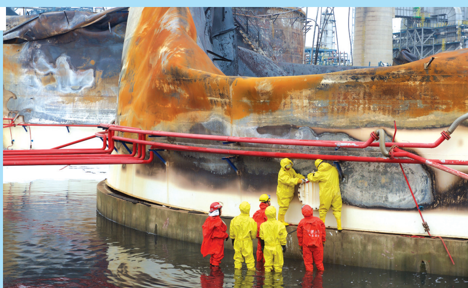
技术人员对大火过后的罐体进行检查 新华社发
