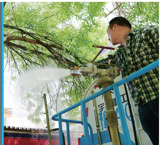
记者离开时看到,鲁师傅在给工地洒水
