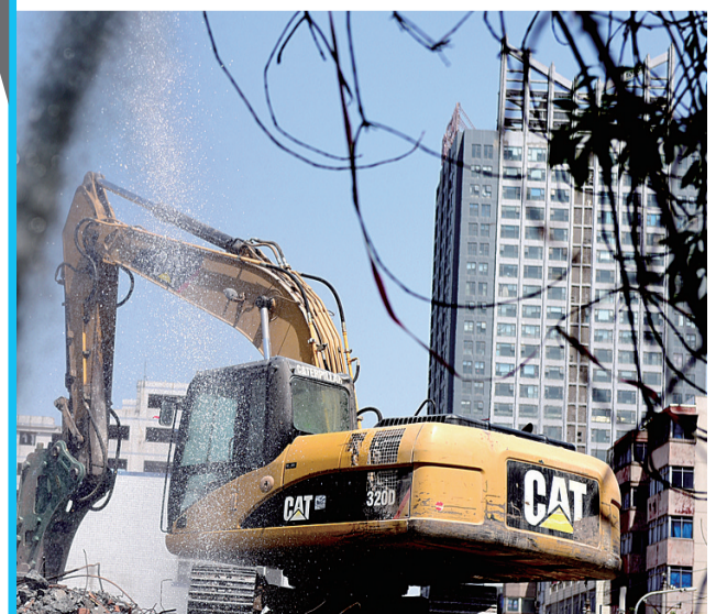
高压水枪为工地降尘
