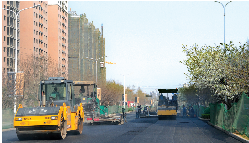
荥阳市住建局施工现场
