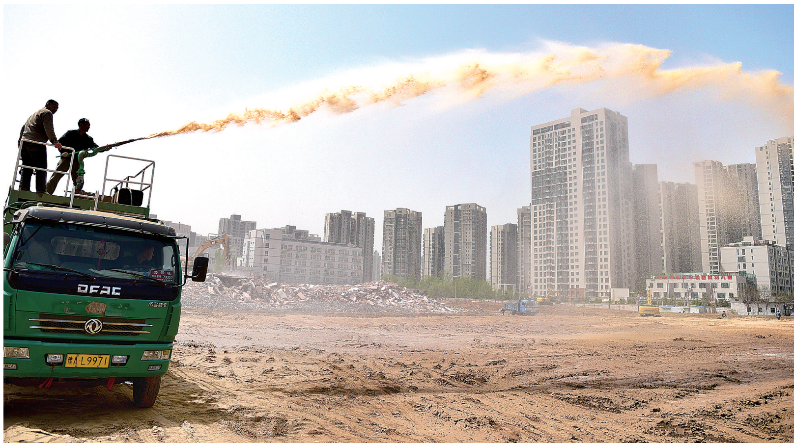
金水区徐寨村拆迁工地,工人在喷播草籽。郑州晚报记者 王军方 图
