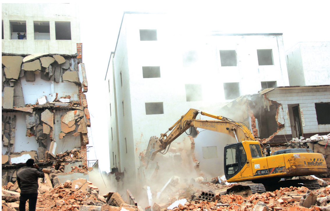
违法建筑拆迁现场
