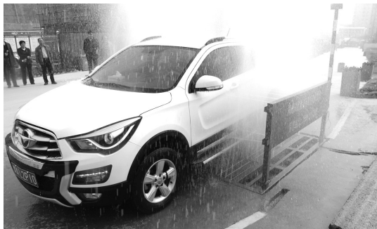
车辆冲洗设施,已成荥阳市工地“标配”。
