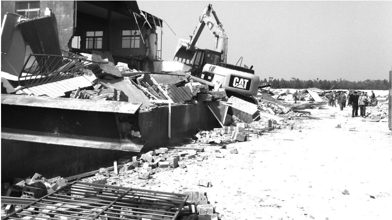
拆除违建建筑工作正在进行中
