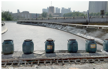
西南侧一条匝道桥已铺上防水
