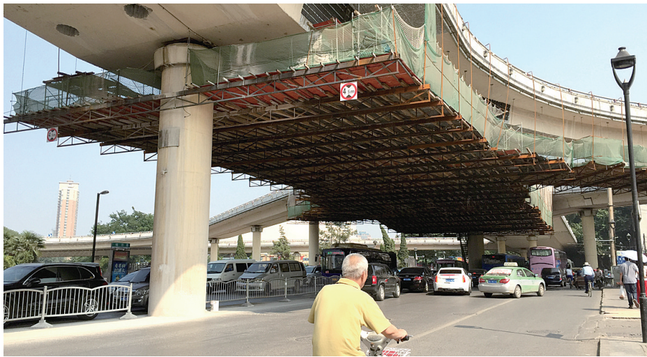
大石桥立交施工现场
