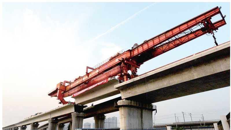
郑机城铁最后一片箱梁成功架设
