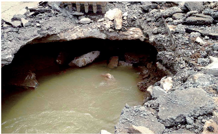
开元路抢修现场
