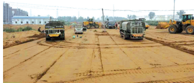
工程正在紧张推进中
