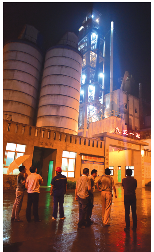
这个车间的除尘设备出了故障
