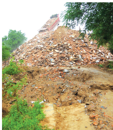
上百车渣土被倾倒在村口,填补塌陷处
