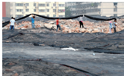
工人在覆盖防尘网
