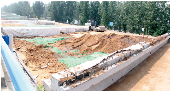
机场高速改扩建工程部分区域已开始覆盖防尘网
