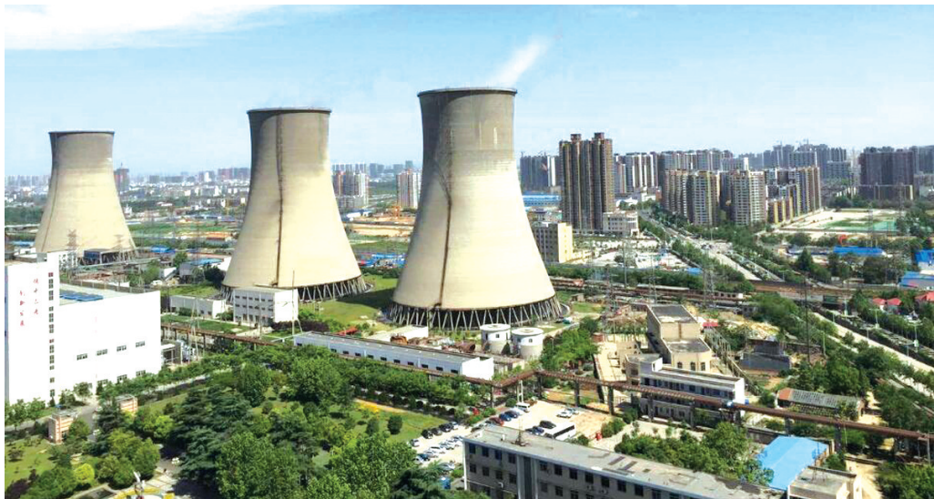
新力电力投1个亿进行机组脱硝改造
