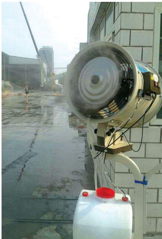
航海路搅拌站增添离心喷雾器
