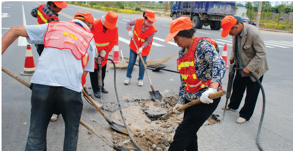
荥阳市交通运输局工作人员正在对公路填补坑槽
