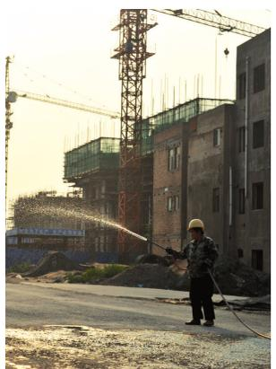
昨日上午,在三官庙华山路村口,拆迁了一半的楼房停止施工,挖好的土坑、堆放的建筑垃圾和施工材料都被盖上防尘网,凡裸露的部位基本都覆盖严密,周围也用蓝色围挡封闭。
