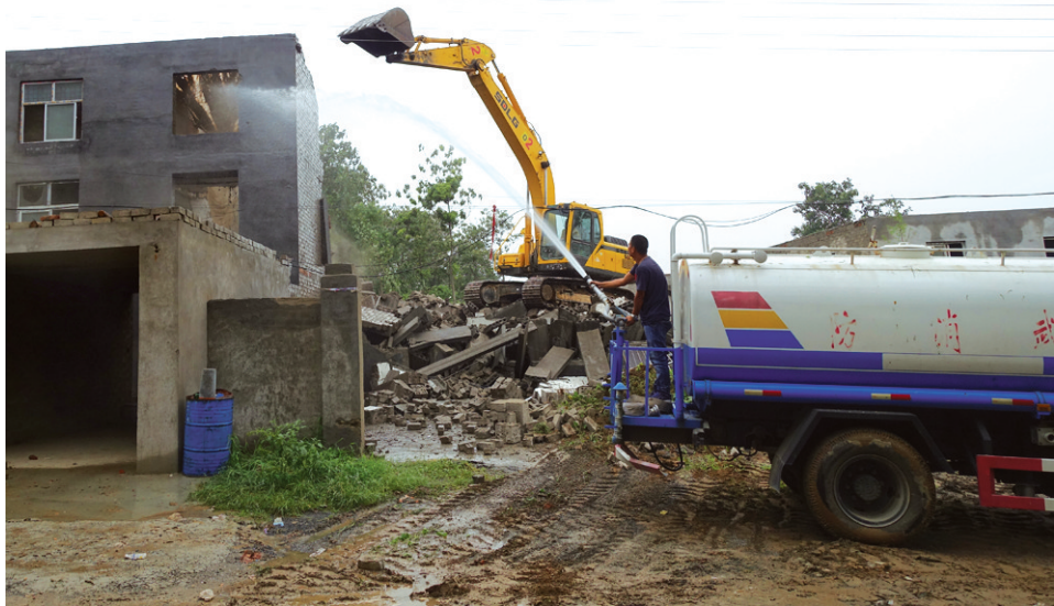
带水作业防扬尘
