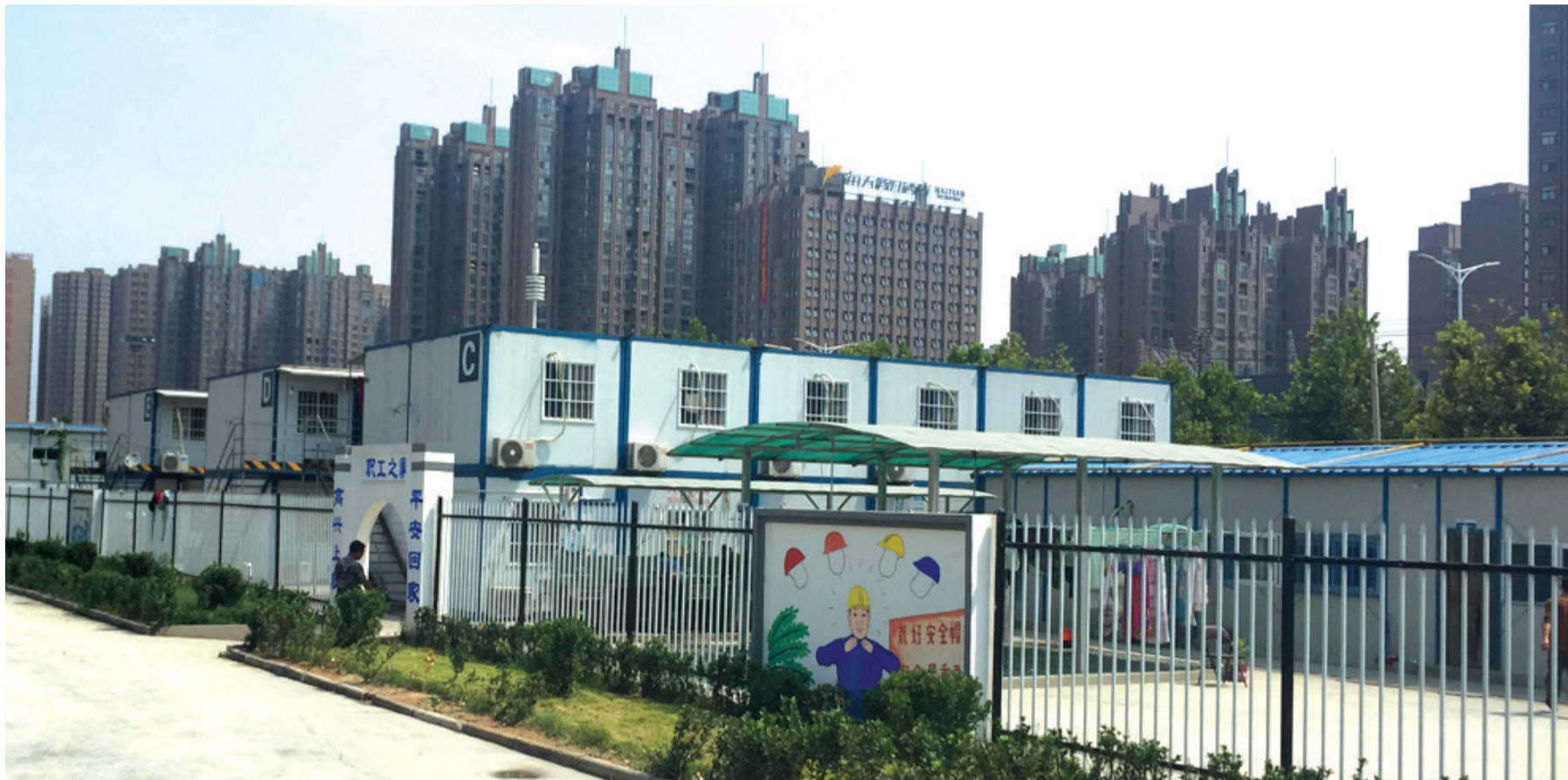
长隆金港项目工地道路硬化
