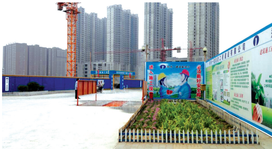
高砦安置房项目工地的绿化和车辆自动喷淋系统
