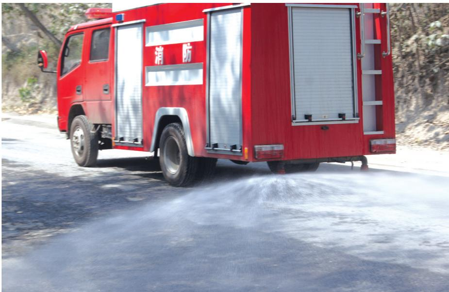
近日,荥阳市贾峪镇为治理道路扬尘使出“新招”——为道路喷洒抑尘剂。据悉,抑尘剂以新的化合物——钙镁络合物为主要成分,它能够有效地把灰尘和土壤相结合,让尘土不再飞扬。其抑尘方式最初主要用于铁路,目前公路方面也已经广泛使用。在内蒙古、西安、新乡已有先例,在荥阳还属于“新事物”。图为洒水车正在喷洒抑尘剂。
