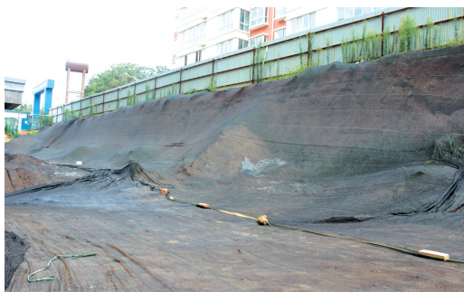
贾峪镇北海小区建筑工地覆盖密目网及围挡
