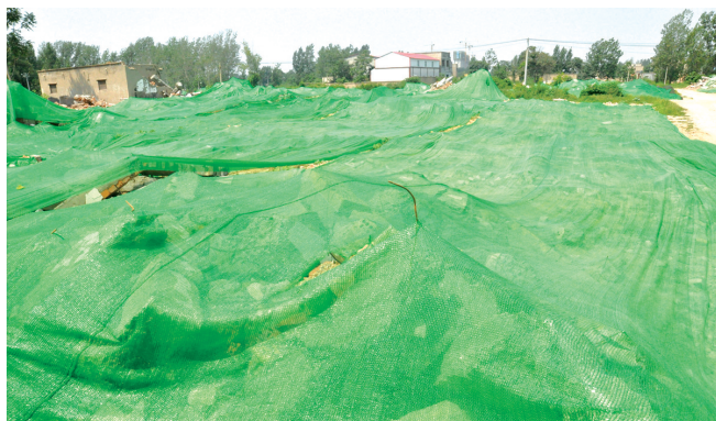
贾堂村工地覆盖防尘网
