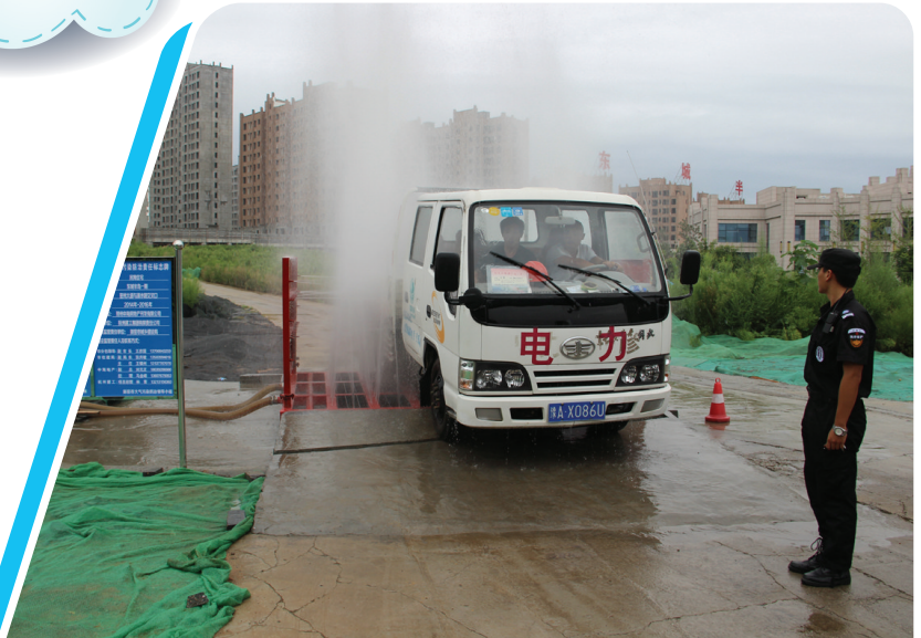
东城半岛出入口正在冲洗货车
