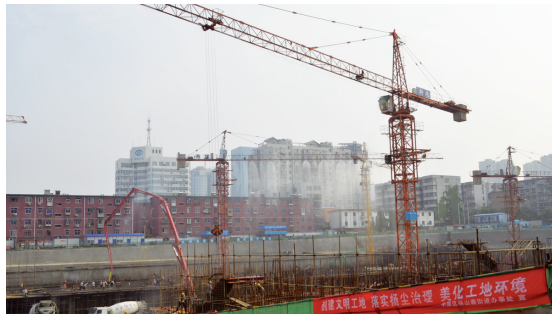
塔吊的吊臂上安装高空喷淋设备,喷水雾降尘
