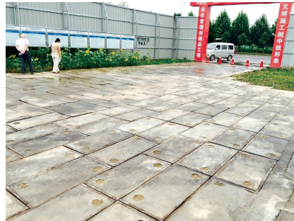
除了使用活动路面,该项目还准备建立建筑垃圾回收利用系统,把建筑垃圾当场变成砖块,用在墙体基构中。 郑州报业集团全媒体记者 冉小平 实习生 李丹妮 文/图
