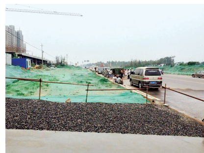
现场各施工材料也进行规范清理,达到整齐堆放,并使用了安全网覆盖。项目南、北两院垃圾废料池已按照标准完成改造,并安装防护网,进行全封闭。 郑州报业集团全媒体记者 冉小平 实习生 李丹妮 文/图
