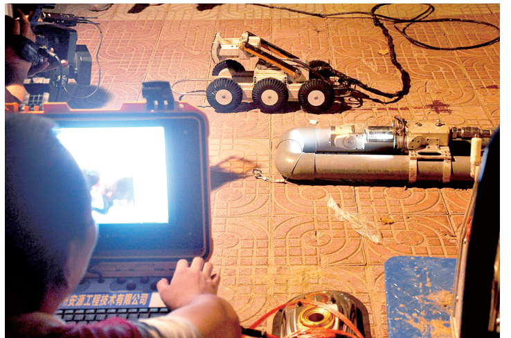
技术人员通过电脑操作机器人,并可看到机器人拍摄的管道内的画面。
