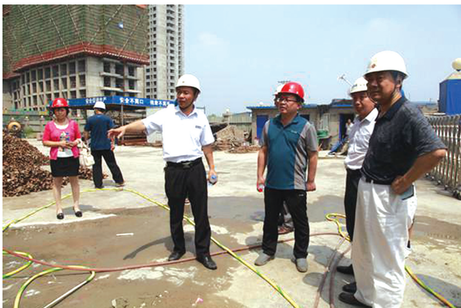
现场督查大气污染治理
