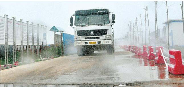
工地道路两旁的喷头在喷淋路面和车辆
