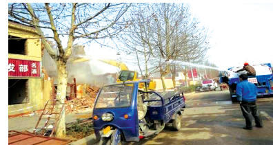
拆迁工地做好降尘处理
