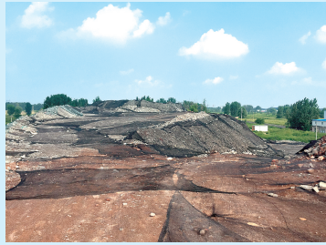
覆盖防尘网,减少扬尘
