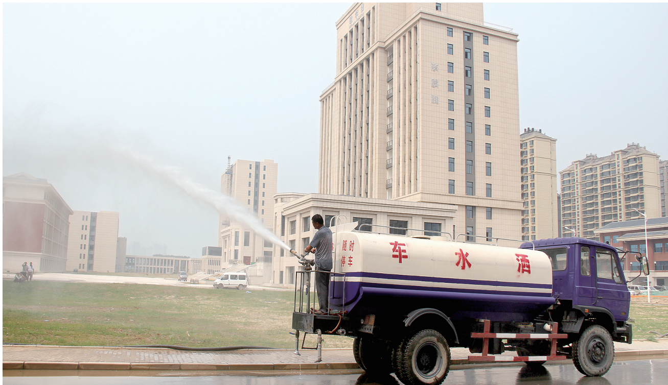
中州大学二期项目工地正在进行洒水降尘作业
