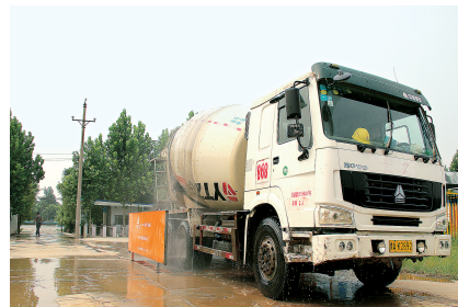
东赵安置区工地车辆出入冲洗
