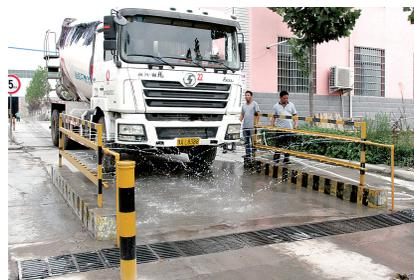
混凝土搅拌站感应冲洗装置
