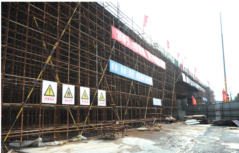
南四环在建高架桥路段
