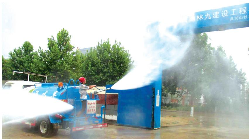
昨日14时,新郑市具茨山社区建设工地内,新购进的新型洒水车同时以地面洒水和高空喷雾方式对工地上下进行了喷洒降尘,工地周边的绿树再也不是“灰蒙蒙”的。
