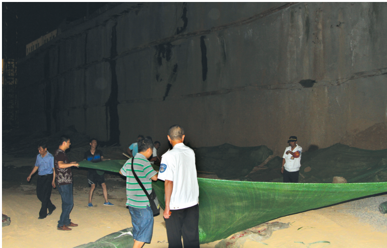
办事处人员加盖防尘网现场
