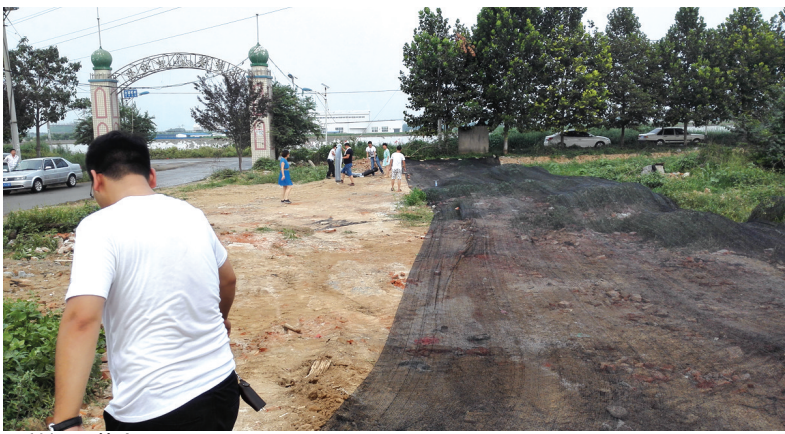
覆盖裸露黄土
