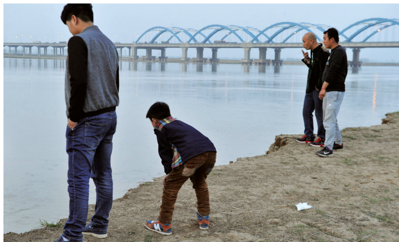
黄河临河岸滩下随时可能坍塌
