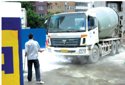
对进出工地车辆进行清洗
