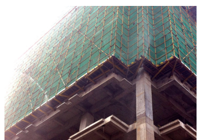
京广路街道工地防尘网覆盖
