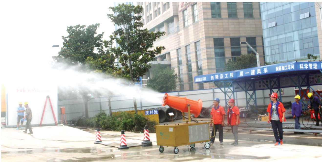
辖区建筑工地内实现喷洒全覆盖
