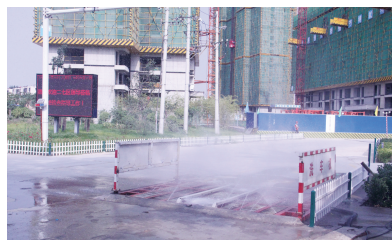
铁道京广家园在建项目
