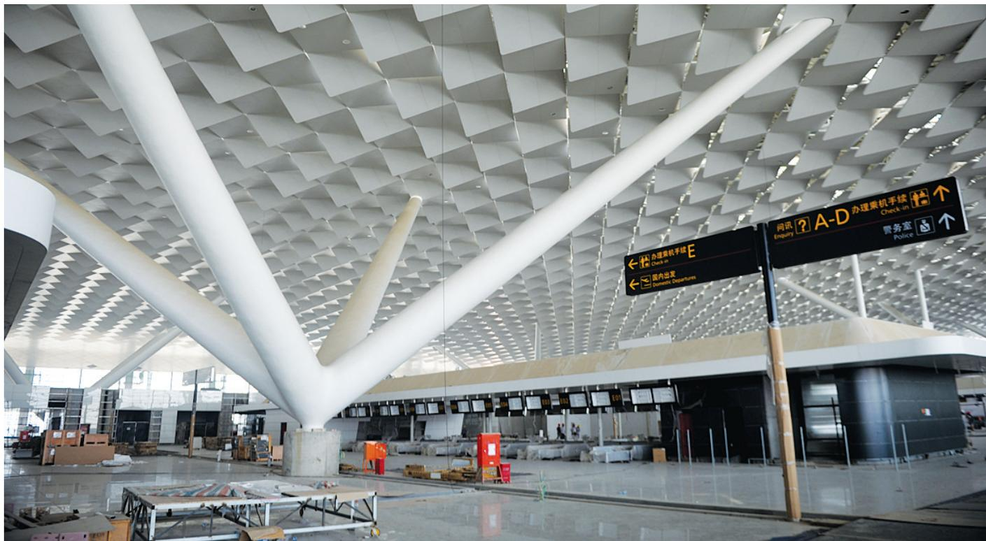
T2航站楼内部建设业已进入尾声,特色鲜明的四岔钢架在大厅内格外醒目。
