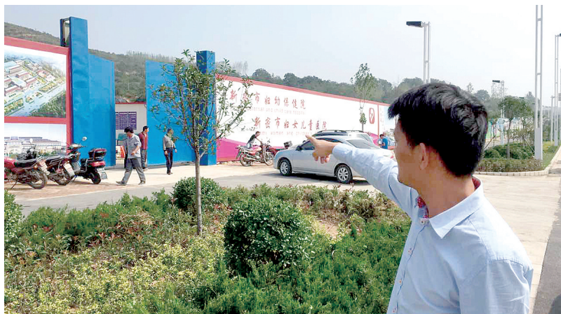
正在施工中的新密市妇幼保健院新址
