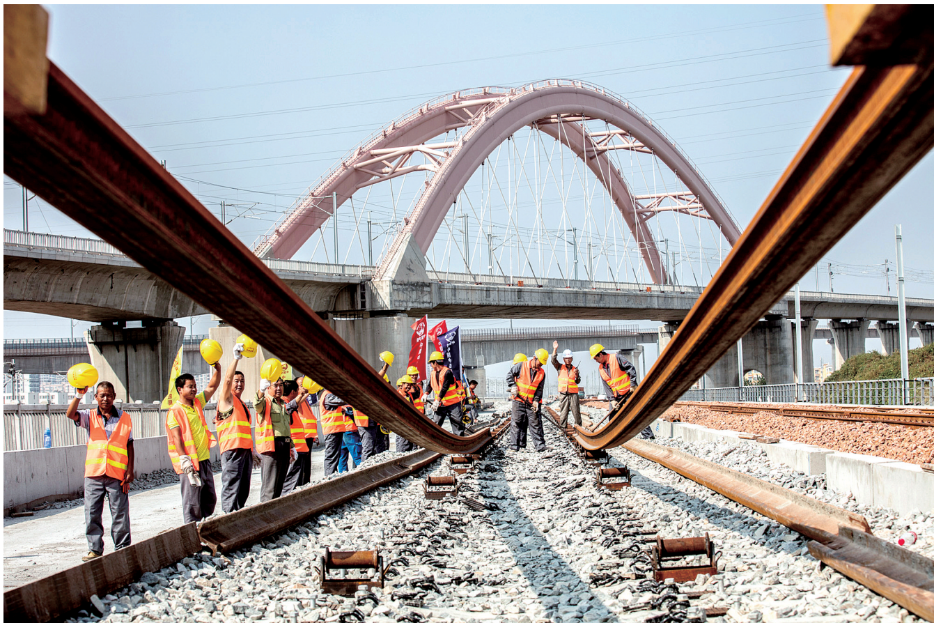
9月25日,施工人员在郑州东站北端郑徐客专施工现场作业。新华社发
