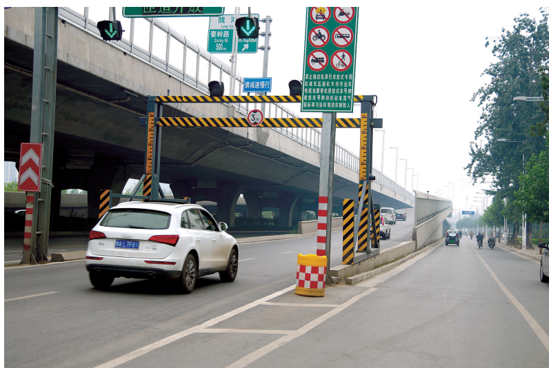
三环快速中原路北向南上桥口,标识3米的限高杆实际4.1米高
